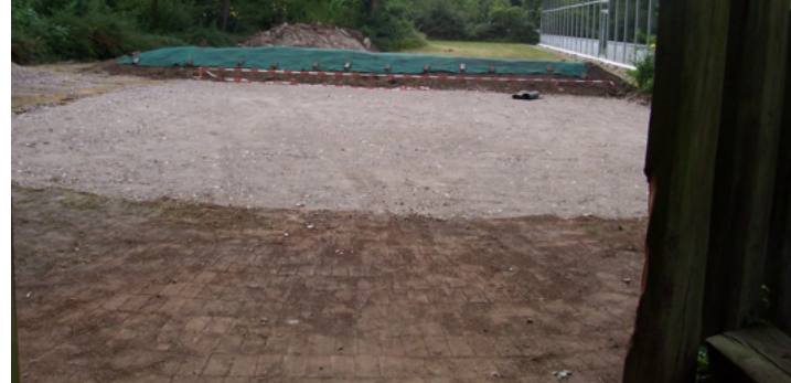
Der Unterbau ist eingebracht (05.07.2010)
