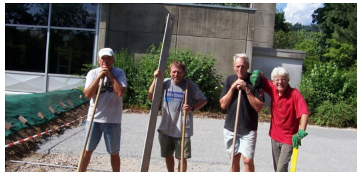
Die fertige Umrandung mit aufgebracht Verschleißschicht (19.08.2010)
